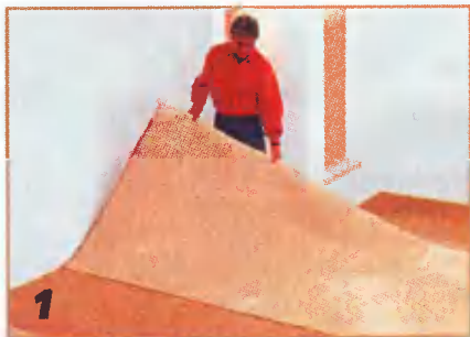
1 Плотнище покрытия свободно расстилают на загнутой основе.
