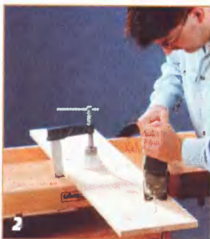
Сначала на щит-заготовку наносят контуры гладильной доски, а затем вырезают её электролобзиком.
